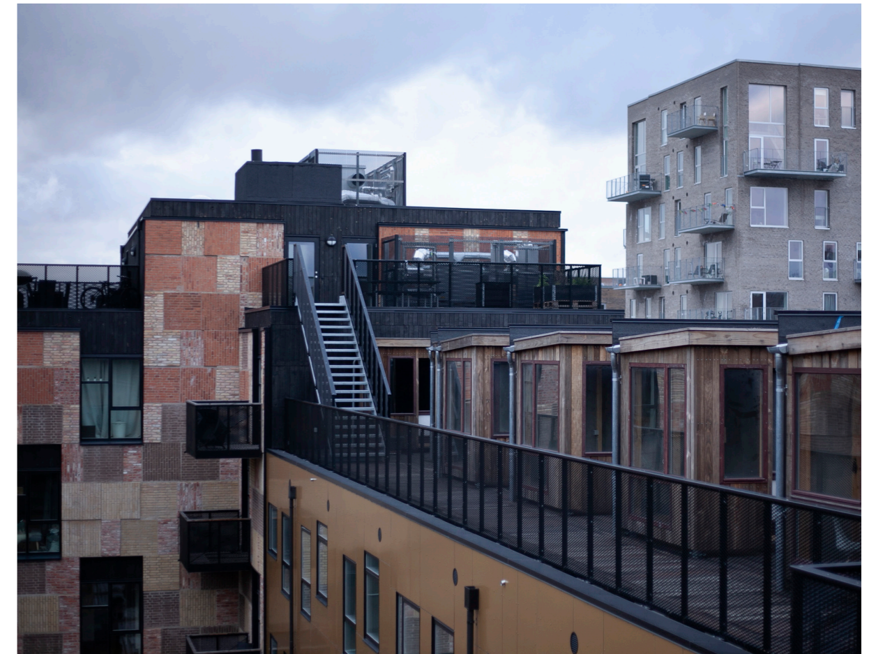
Ressourcerækkerne i Ørestaden har drivhuse på taget bygget af genbrugt træ.
