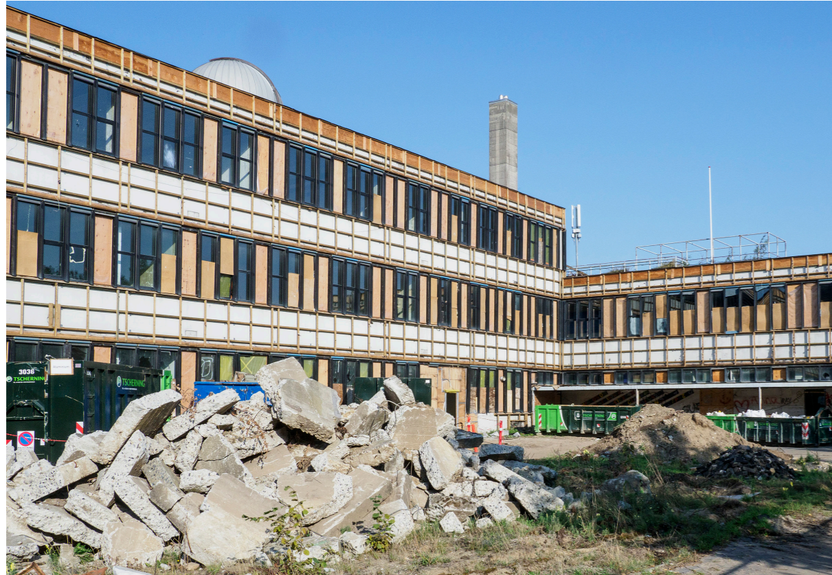
Nedrivning af en gammel skole i Gladsaxe (foto af Schiller).
