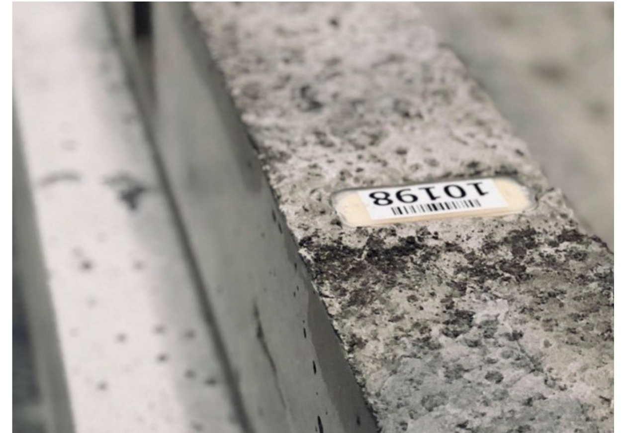
Spæncoms indstøbte chips kan monitorere betonelementernes tilstand.
