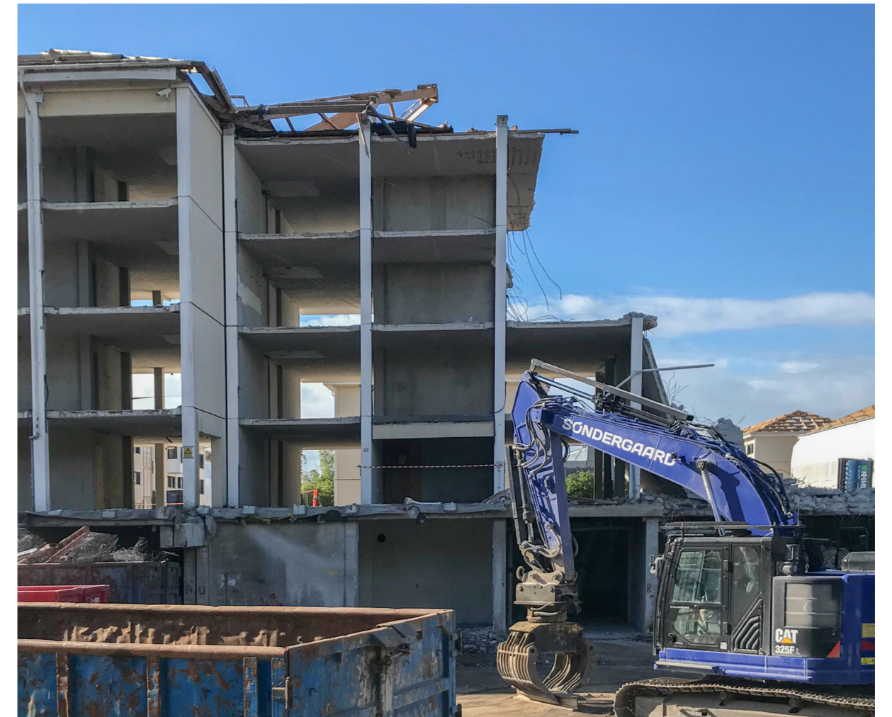
Ansvarlig og struktureret nedrivning.
