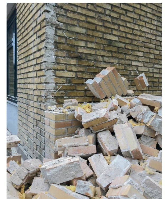
Gamle mursten kan genbruges.
