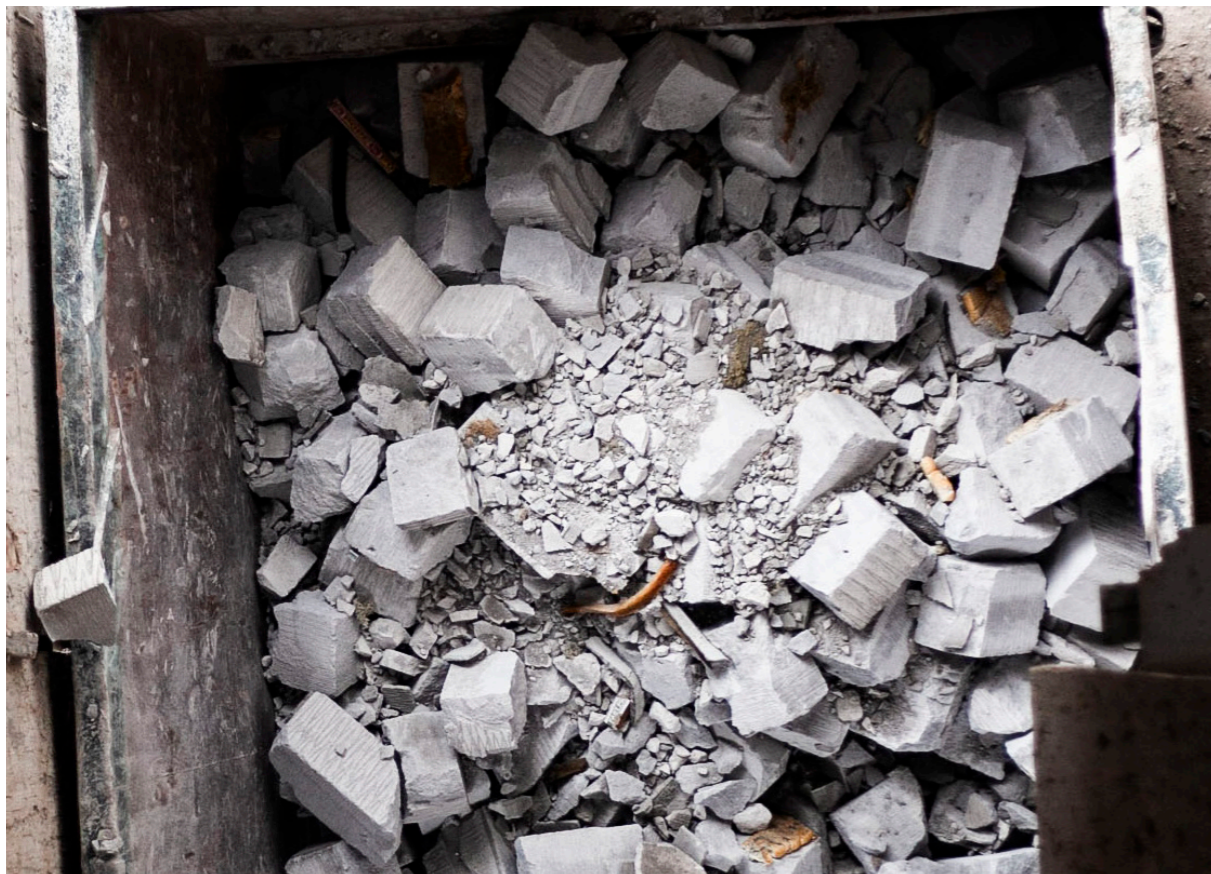
Genanvendele af knust beton.
