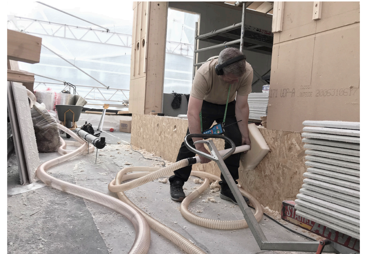
Indblæsningsisolering af Woodfiber AIR.
